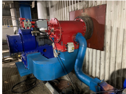
光大环保技术装备(常州)有限公司 Everbright Environmental Protection Technology Equipment (Changzhou) Co., Ltd
