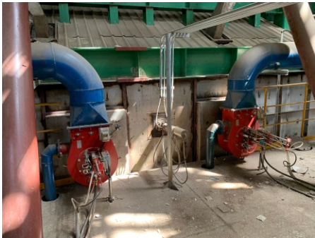
安徽海螺川崎工程有限公司 共32个项目 Anhui Conch Kawasaki Engineering Co., Ltd. has a total of 32 projects
