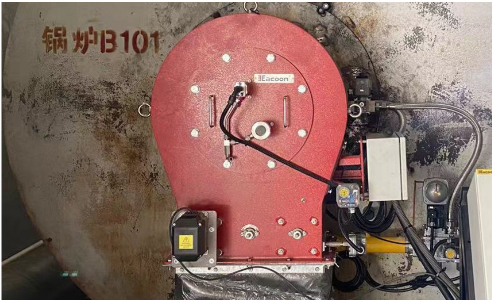
广东子延盛科技有限公司3吨分体机 Guangdong Ziyansheng Technology Co., LTD. 3 tons split burner
