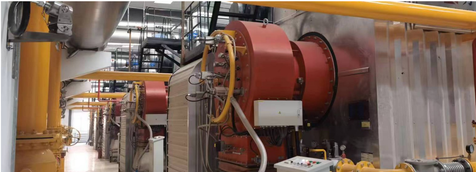
新疆绿翔天源热力有限责任公司军区总医院 两台20吨低氮改造项目 2 sets of 20 tons projectsin Urumqi, Xinjiang
