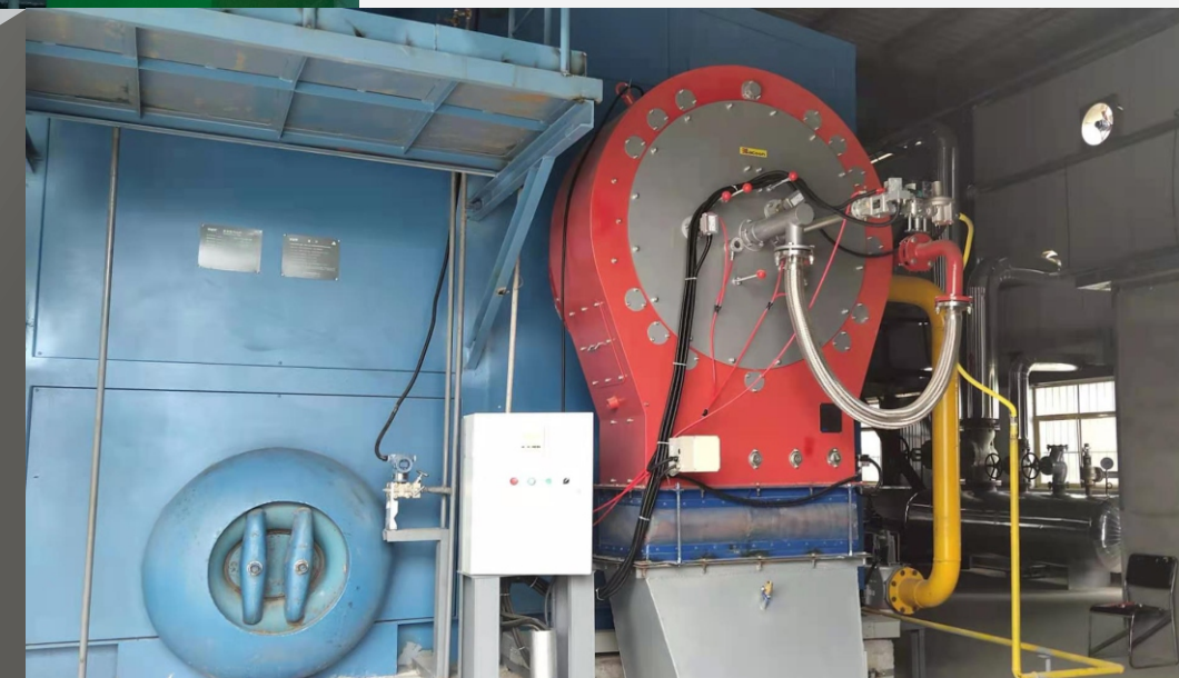
▼ 陕西丰仓原农业科技有限公司 45吨超低氮燃烧器项目
