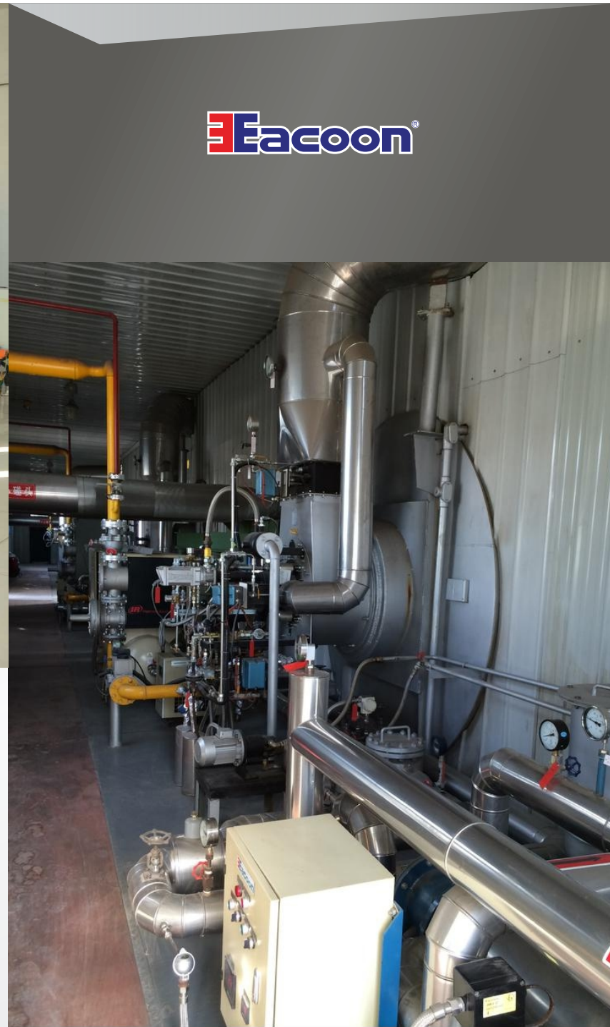
中石油庆铁线三站6台6.5MW重油/天然气燃烧器 ►
