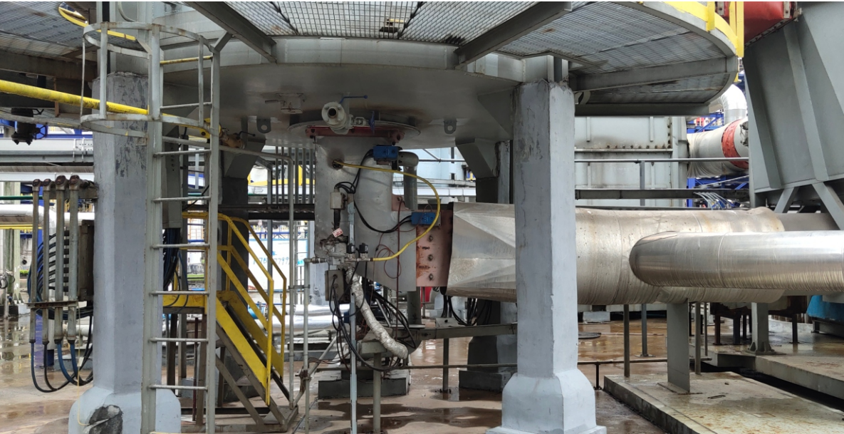
▲ 中海石油宁波大榭石化有限公司 2台20吨燃烧器
