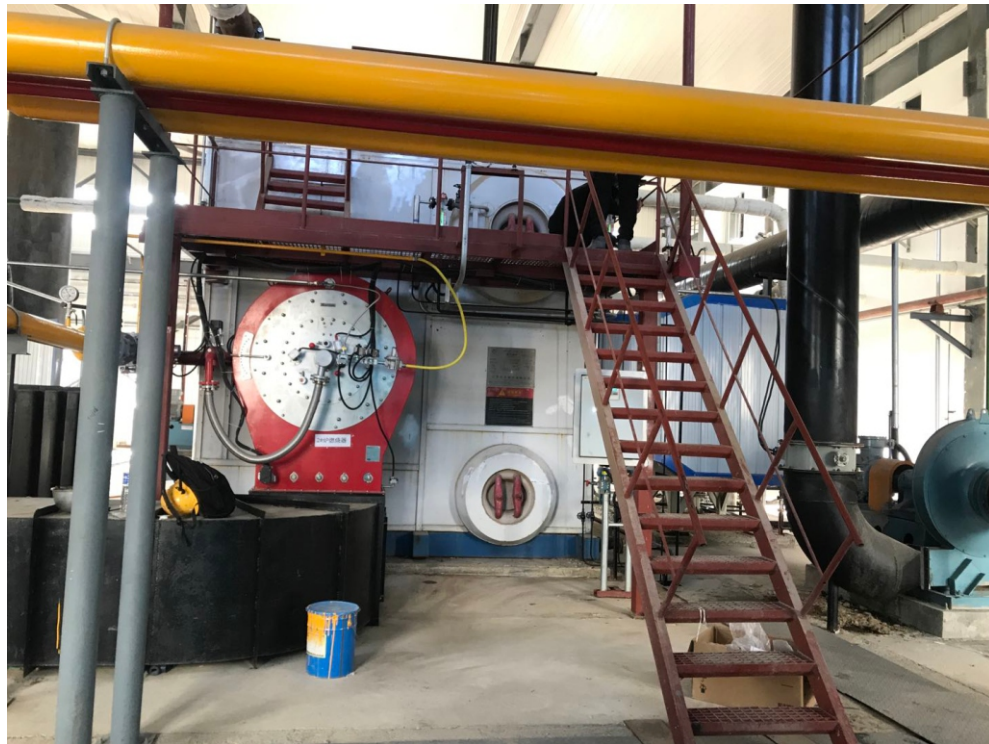
◀ 河北唐山鑫丰锂电 2台25吨超低氮燃烧器项目
