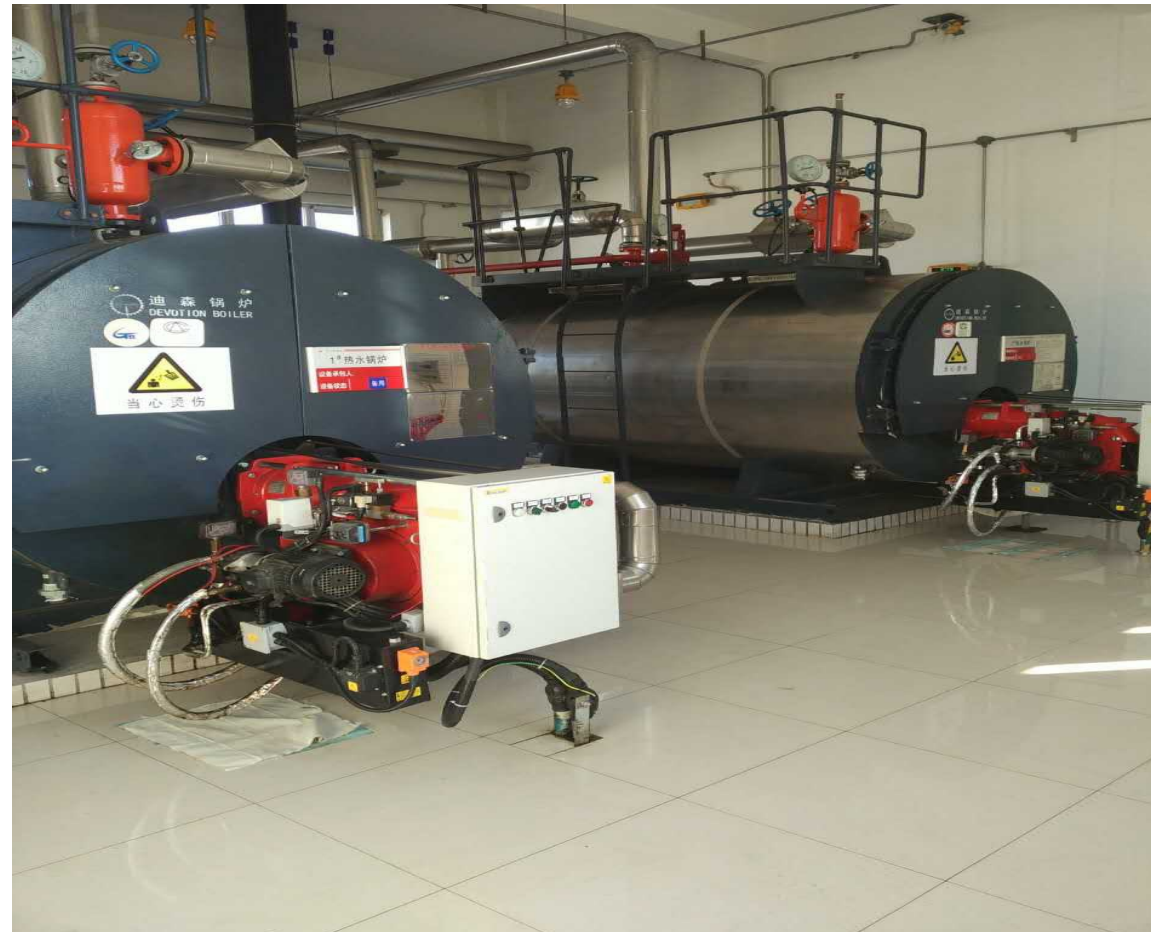
▲ 中石油 铁锦线5站11台5MW重油/天然气燃烧器
