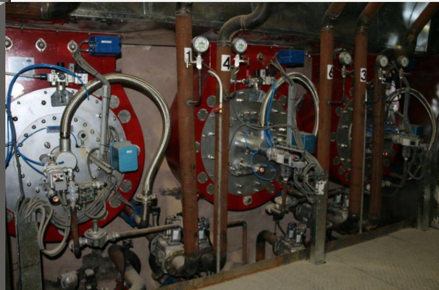
▼ 新疆克拉玛依电厂 130吨锅炉燃烧器改造项目, 配6台20吨低氮燃烧器项目
