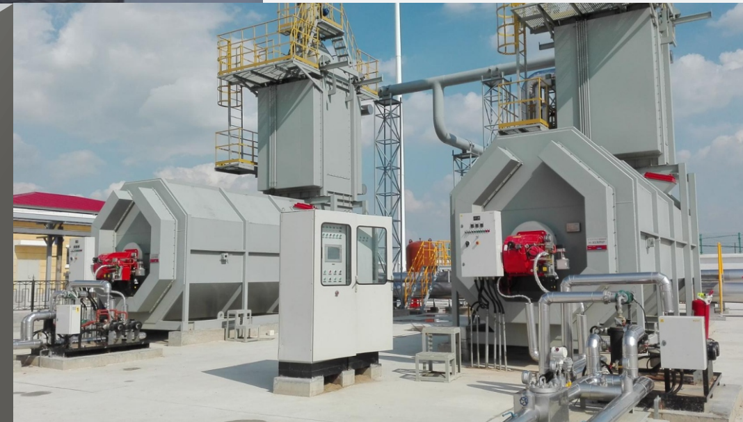
▼ 中石油津华线一站 2台7MW重油/天然气燃烧器
